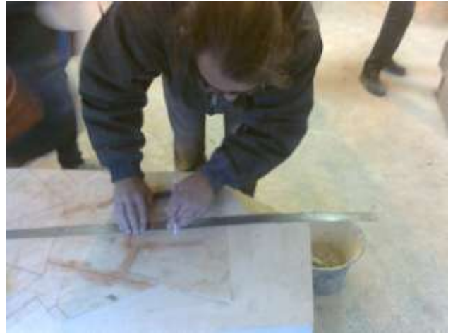
Fig.5-6-7 Taille d'un des chapiteaux qui reçoit le tierceron, le formeret et les diagonaux.
